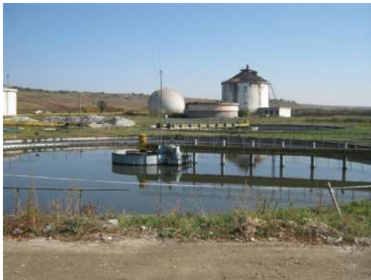
Foto: Stația de epurare Botoșani
